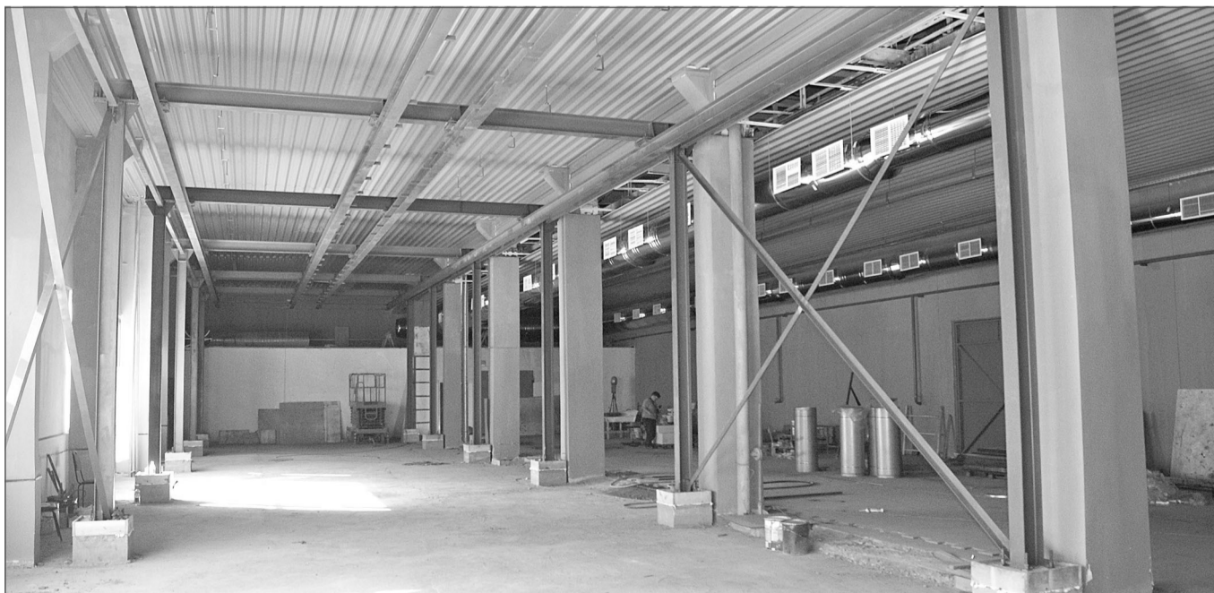
В корпусе «К» завершается работа по восстановлению гальванических участков.
