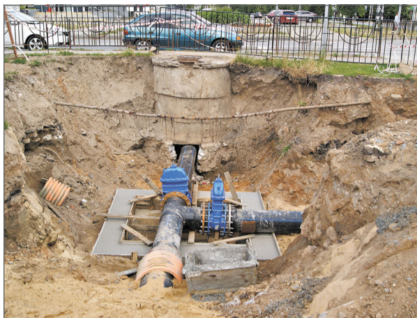
Ремонт водопроводной линии на ул. З.Космодемьянской.
