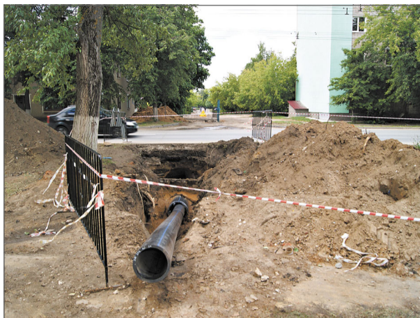
Прокладка водопроводной линии методом ГНБ на ул. О. Кошевого.
