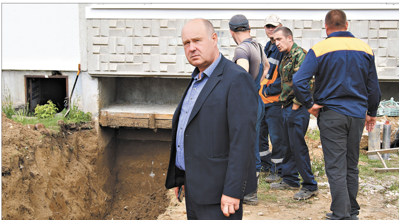
Начальник цеха №63 В.А. Соловьёв на объекте. Ремонт водопроводного ввода в дом на ул. Маяковского.
