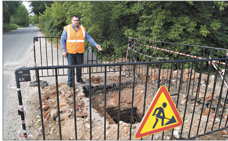
Ремонт канализационного колодца на ул.Кузнечной.
