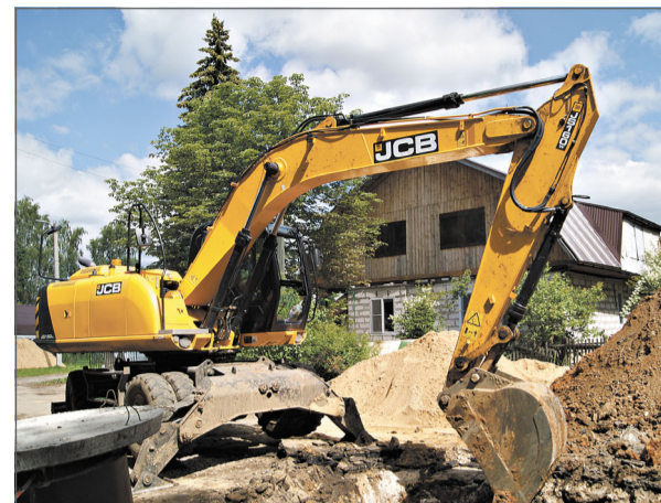
Ремонт канализационного коллектора на ул. Летней.
