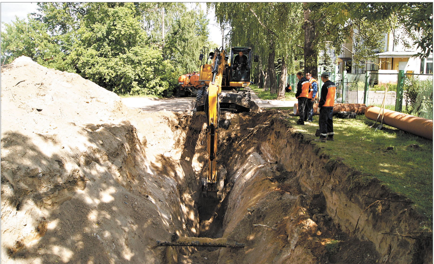
Ремонт канализационного коллектора на ул. III Интернационала.
