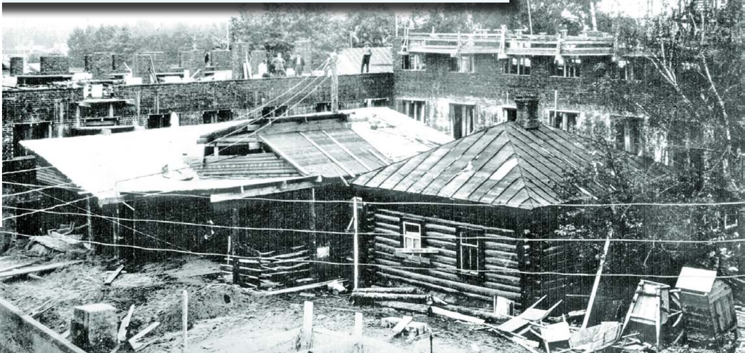
Строительство заводского посёлка.
