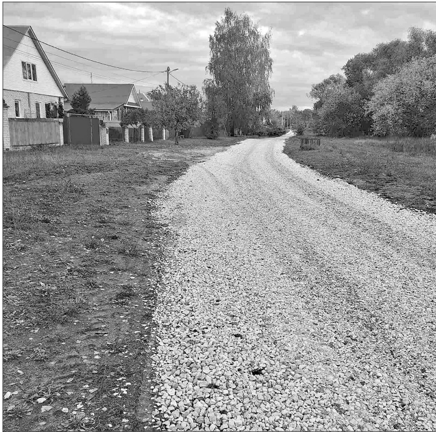
Ремонт дороги в Заречной Слободке.
