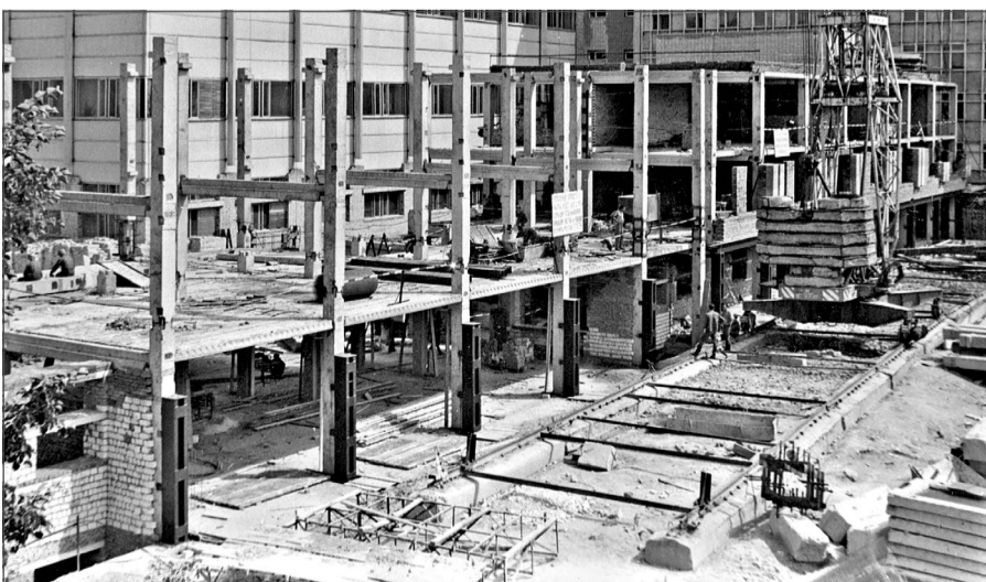
Строительство корпуса «К».
