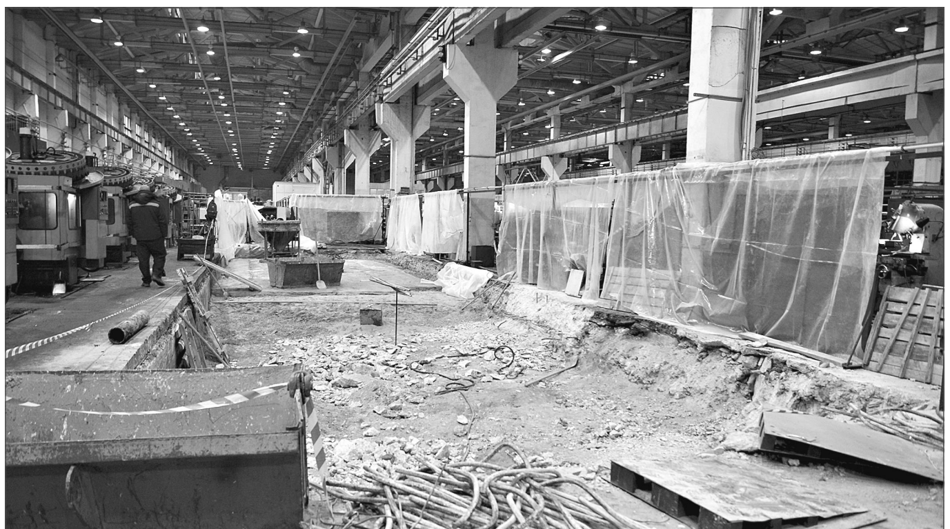
Подготовка места для новых станков.
