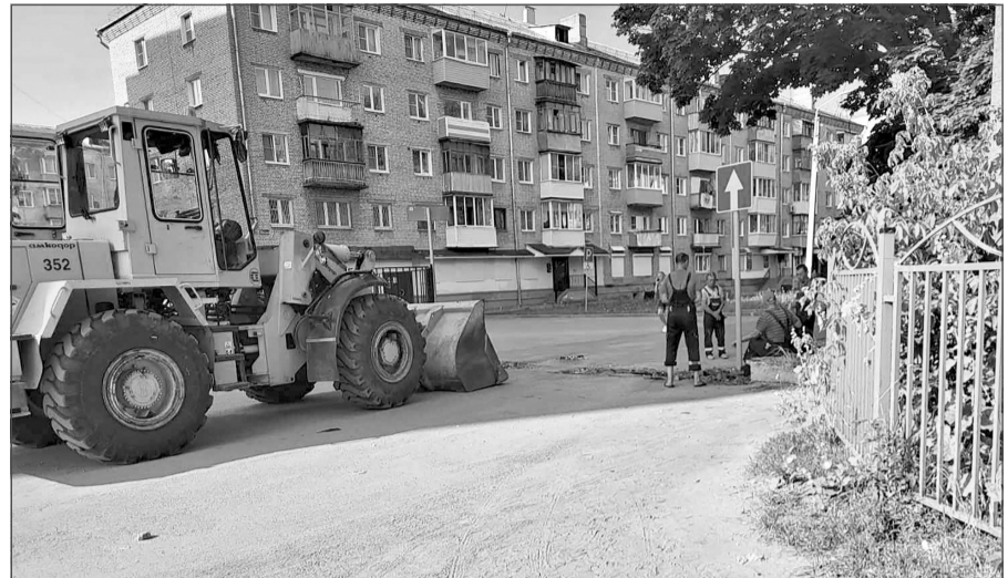
Демонтаж тумб на ул. Ногина.
