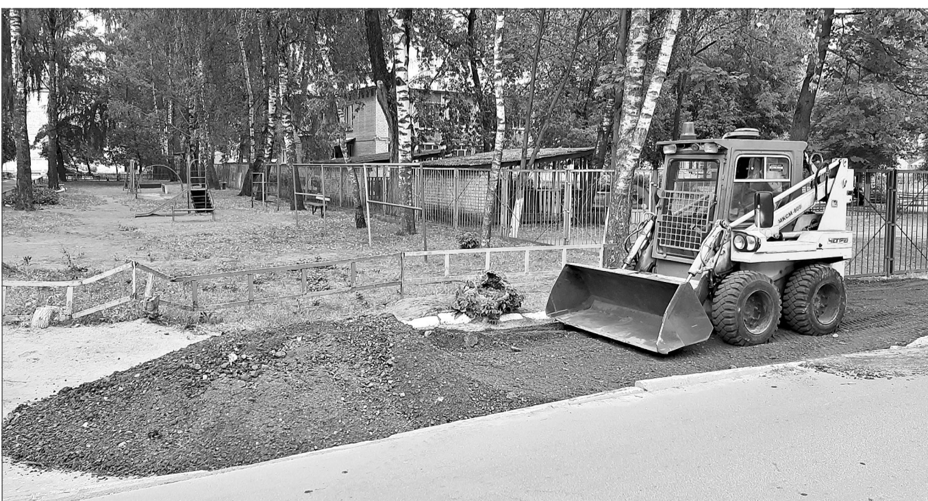
Работы по подсыпке тротуара вдоль ограждения детского сада № 41 по ул. Ногина асфальтной крошкой.
