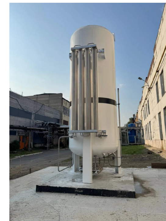
Газификатор ГХК 8/16-100 с испарителем ИА-100/40 (Общий вид)
